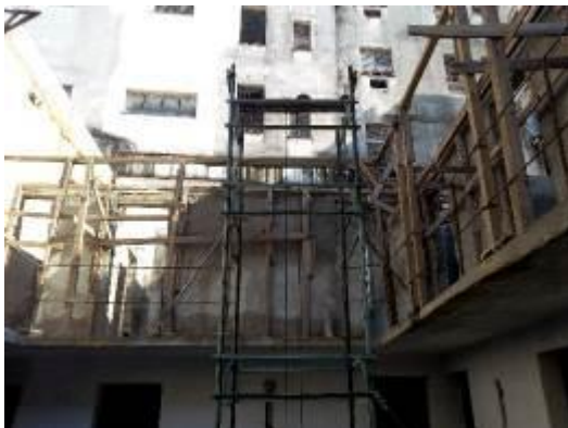
Encofrado parcial para hormigonar losa de entepiso, vigas y columnas para colocación de vigueta y bovedilla en el nivel +10.80m
