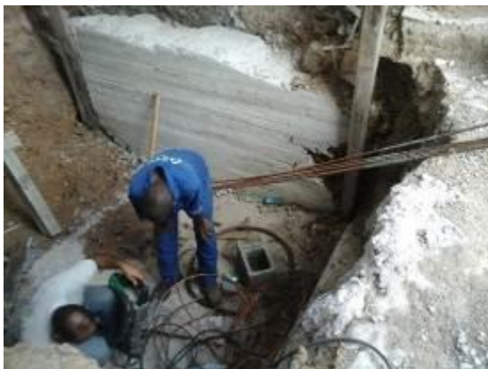
Realización del aterramiento del sistema eléctrico del inmueble
