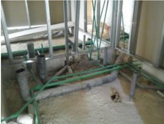
Instalaciones hidráulicas y sanitarias del nivel +4.85 m
