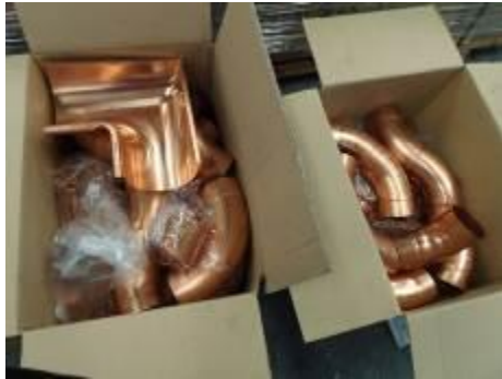
Apertura de los suministros de los canales, bajantes pluviales de cobre y sus accesorios
